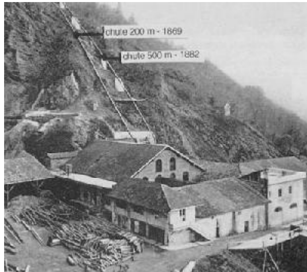
Les papeteries Bergés avec les 2 chutes (200 et 500m)
